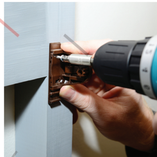
3. Vastavate kruvidega kinnita kronšteinid aknaraamile (vasak/parem)
